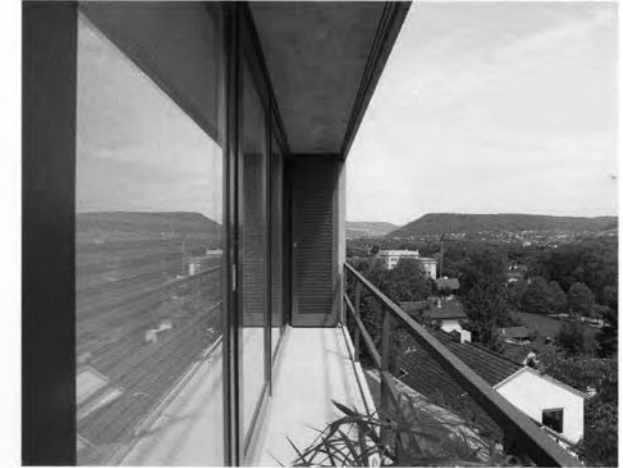
Hinter der südlichen Fensterfront im Obergeschoss befinden sich das Bad und der Schlafraum. Vom schmalen fassadenbündigen Balkon geht der Blick in die Ferne.
