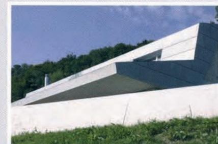
Die Metalleinkleidung bildet sowohl Wand, Dachfläche und Leibung und bildet einen gelungenen Kontrast zum ansonsten einfachen und klaren Baukörper in Stahlbeton.
