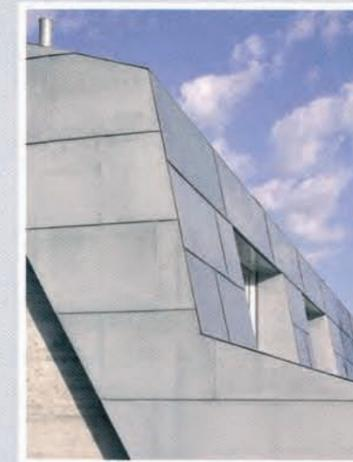
Element. Durch die Verwendung einer Dachhaut aus rautenförmigen Kupfer-Titan-Zink-Schindeln wird dieser körperhafte Eindruck unterstützt und umgesetzt.
