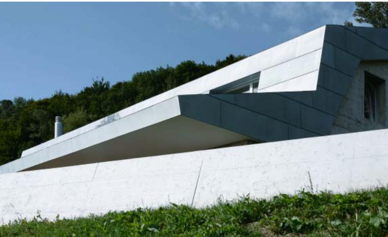
tersichtsbekleidung erlaubt den Lufteintritt in das hinterlüftete Rautendach. Lamellenförmige Öffnungen im Firstbereich ermöglichen den Luftaustritt.
